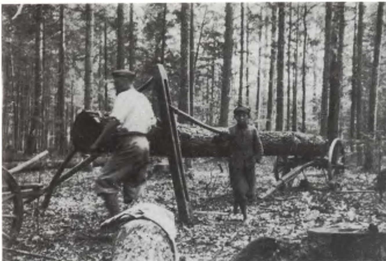
Fot. 3. Ładowanie kłoca na wóz za pomocą tzw. „lody”. Chłopiec trzyma rękę na dźwigni a ojciec podciąga pod wiszący koniec kłoca tzw. „przodek” od wozu.
