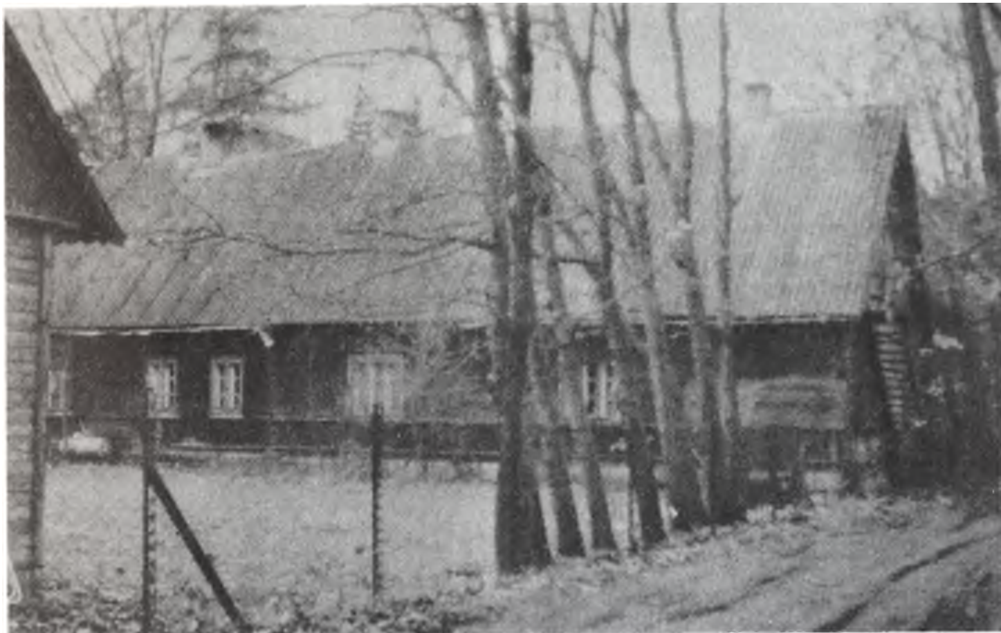
Fot. 57. Budynek Jagdhausu (Domu Myśliwego), w którym zamieszkiwał i został zabity Anton Krüger, po 47 latach. Dwa duże okna należą do Sali Myśliwskiej. Następne dwa okna wychodzą z korytarza. Ostatnie okno oświetla hol (sień). Dalej było mieszkanie Krügera (południowy szczyt budynku). Zamiast widocznego płotu z siatki był wysoki, szczelny płot z desek. Wejście w podwórkę - jak na zdjęciu. (Obok widocznego częściowo budynku gospodarczego). Tym wejściem przechodzili zamachowcy, idący zabić Krügera.
