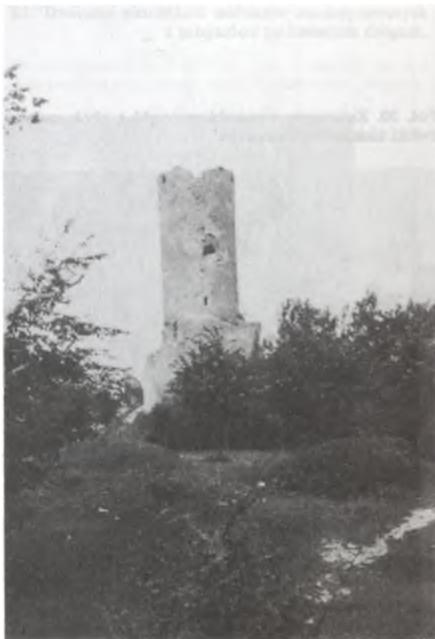
Fot. 32. Wieża zamku iłżeckiego okaleczona niemieckim pociskiem.
