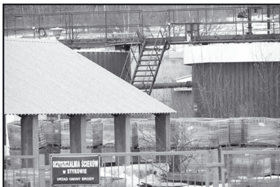
Oczyszczalnia ścieków w Stykowie
