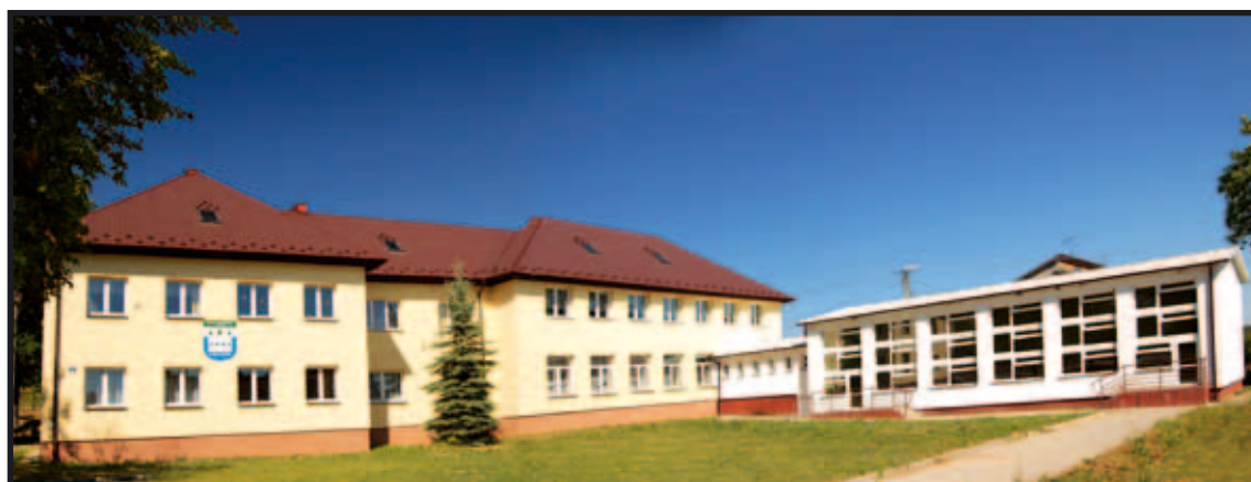
Szkoła podstawowa w miejscowości Brody (Połagiew) – stan obecny
