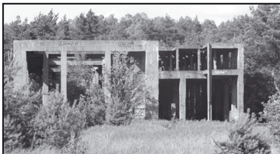
Niedokończona budowa elektrociepłowni w Stykowie – okres międzywojenny
