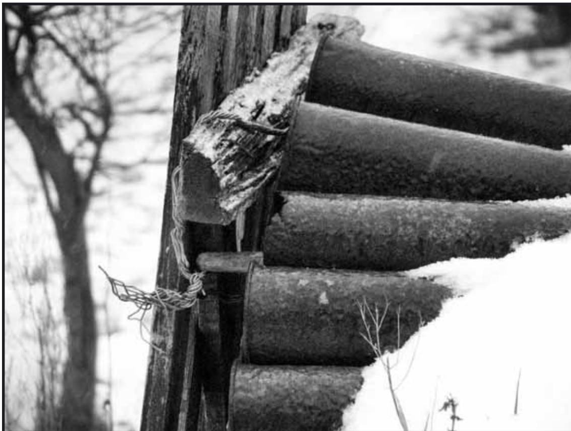
Świadectwo z tamtych dni – wejście do piwnicy, wykonane z łusek armatnich
