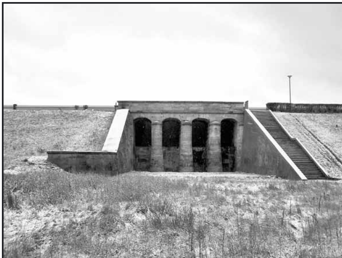
Zrekonstruowany fragment starej zapory
